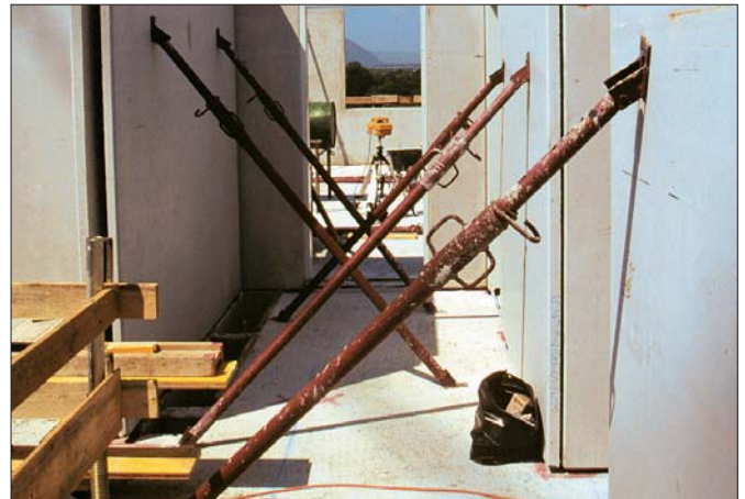
Bild 14: Sicherung der Wandelemente mit Schrägstützen
