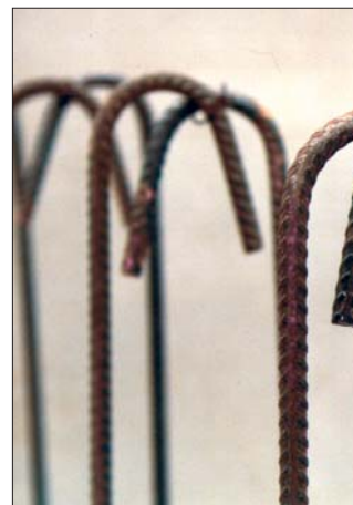
Bild 3: Steckseisenendhaken zur Wandmitte ausrichten
