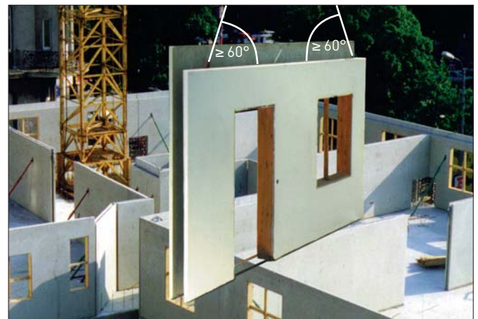
Bild 8: Das Element am Kran
