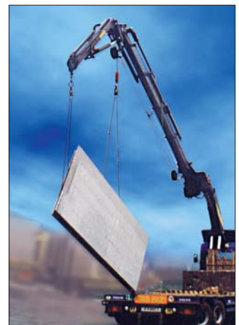
Bild 11 und 12: Beim Aufdrehen von liegend-stehend ausgelieferten Wandelementen sind zwei Seilwinden am Autokran bzw. Mobilkran erforderlich.
