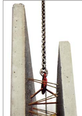
Bild 4 und 5: Element an den Auslegern anschlagen
